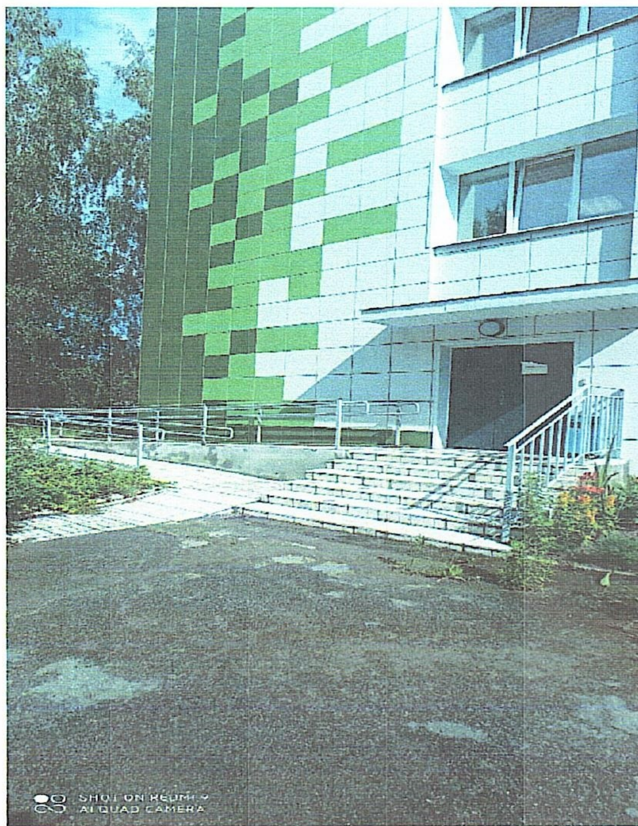
Фото № 2 Вход оборудованный пандусом Лестница наружная
