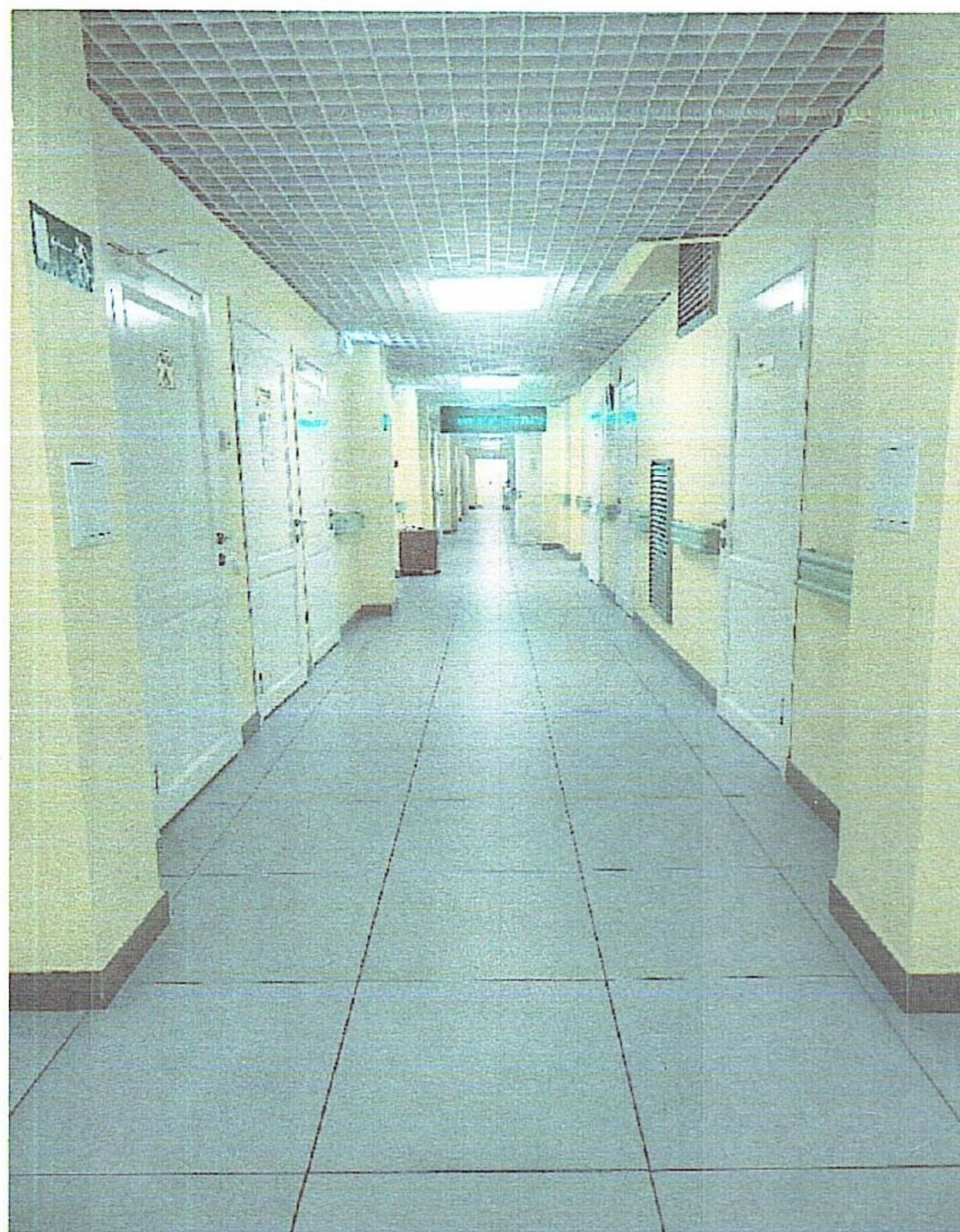
Фото № 18 Зона обслуживания (кабинеты 3 этаж)(1 этаж)
