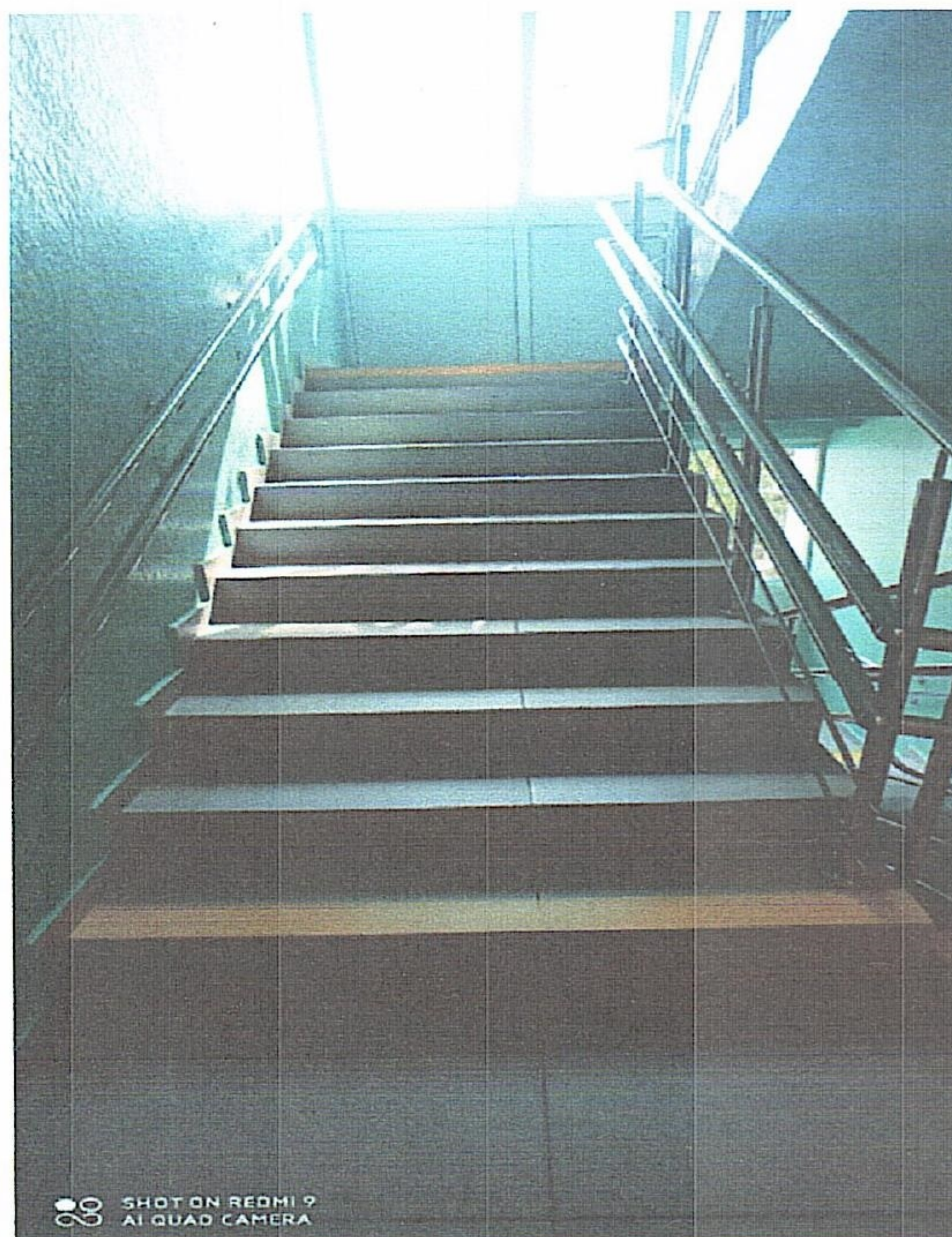
Фото № 8 Лестница внутри здания
