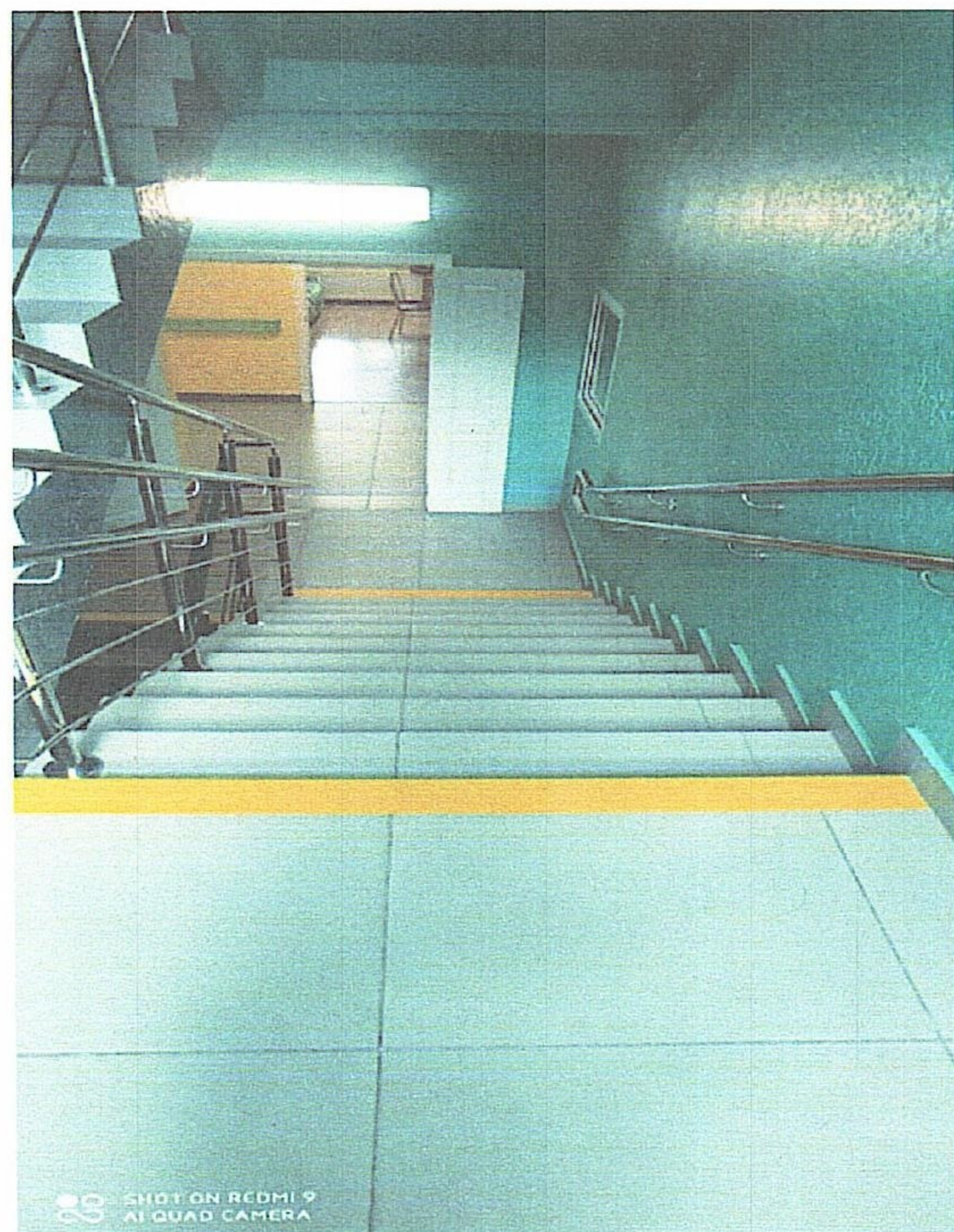
Фото № 7 Лестница внутри здания
