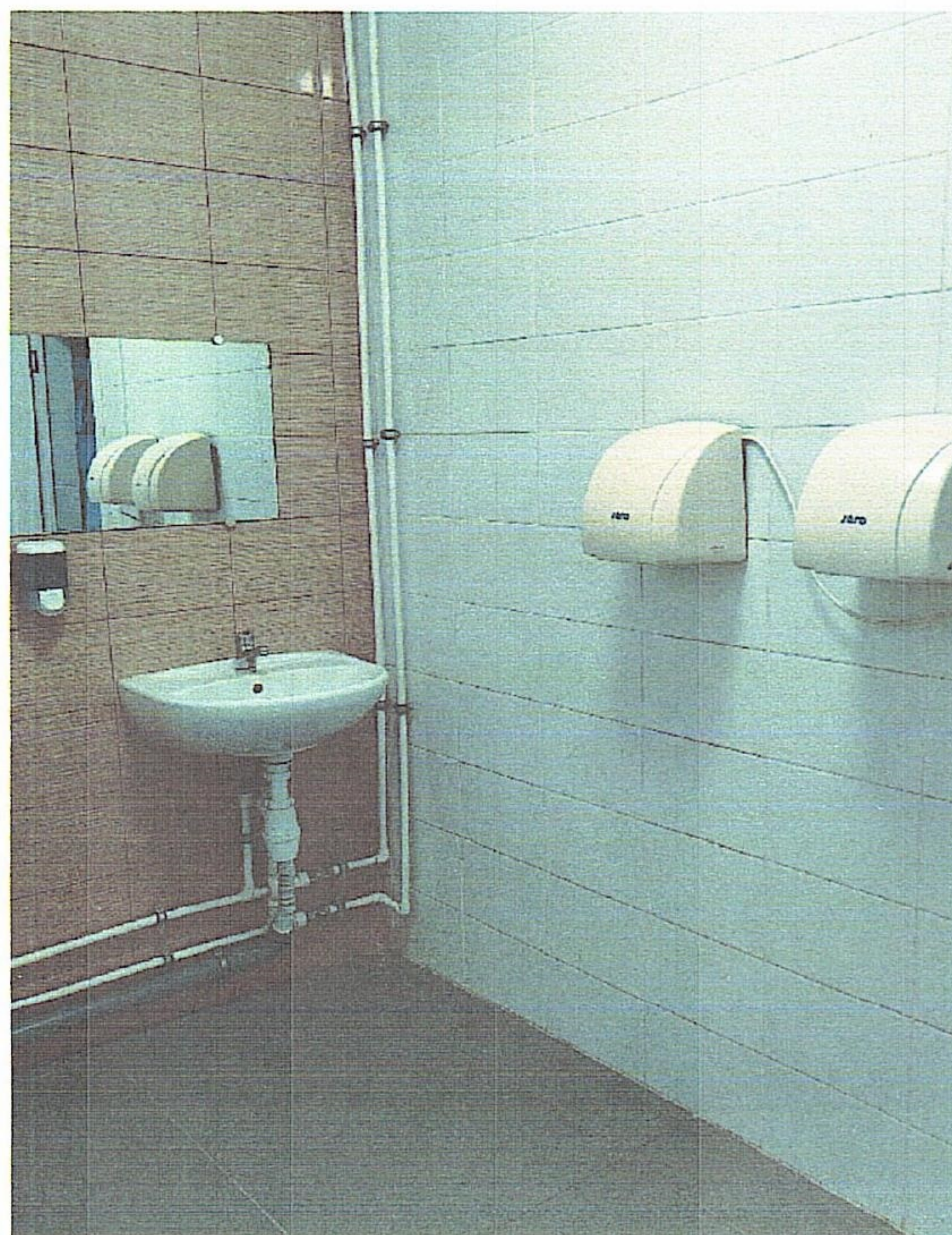
Фото № 24 Санитарно-гигиеническое помещение 3 этаж
