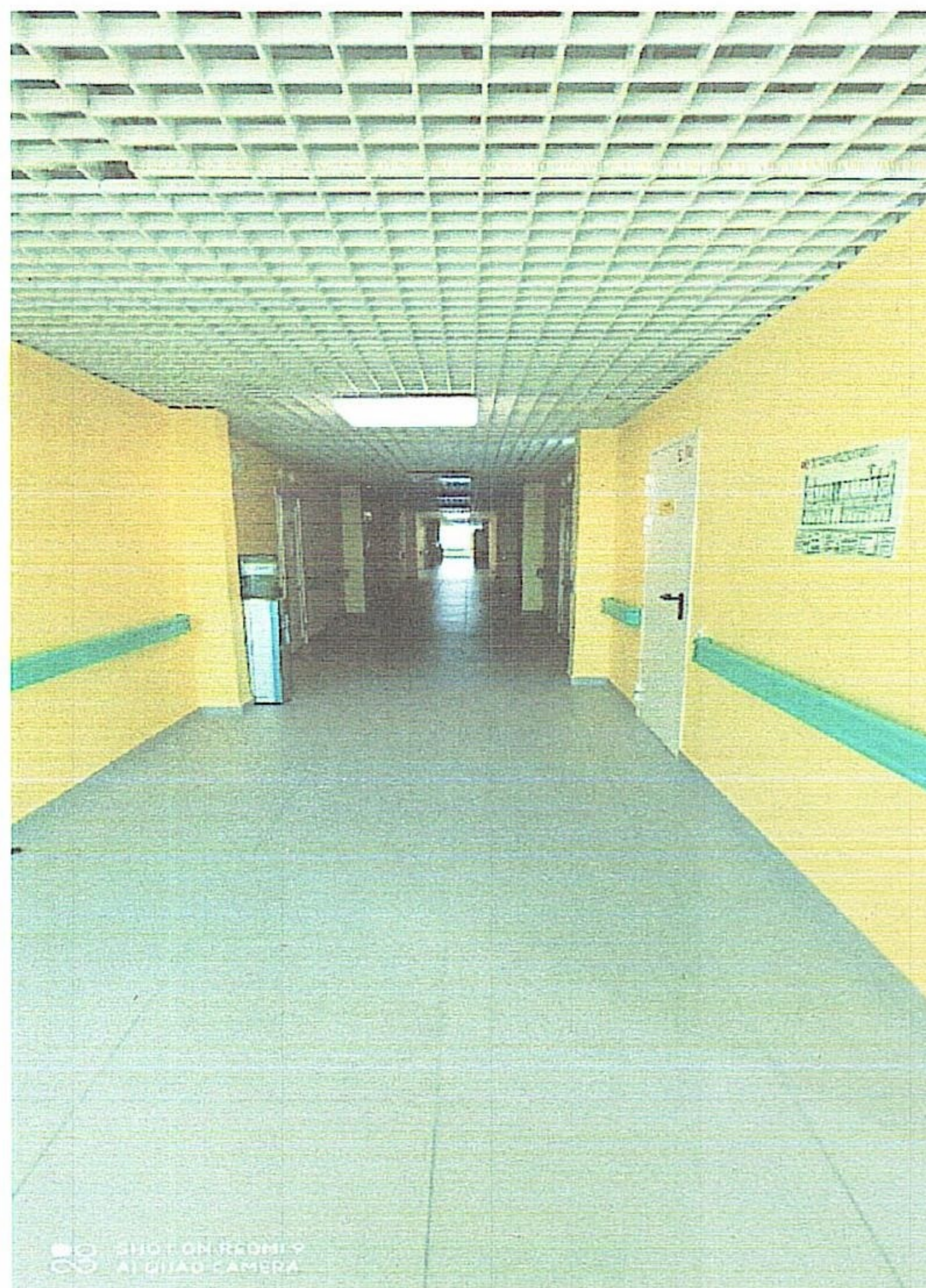
Фото № 6 Коридор (3 этаж)
